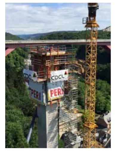
Une plateforme pesant près de 6 tonnes a été accrochée à la tour en béton armé à l'aide de 6 ancrages.
