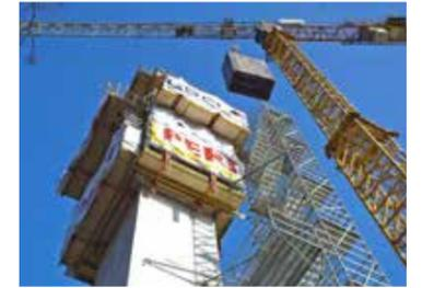
Un coffrage grimpant avec coffrage de voile PERI VARIO pour réaliser la partie verticale en béton architectural
