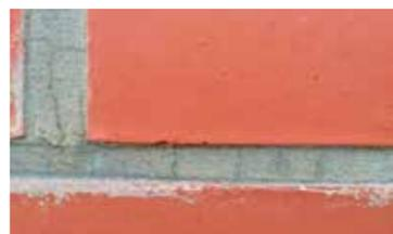
Fig. 3 Fissures générées par des dilatations hygrothermiques et/ou des mouvements du support
